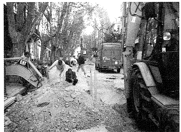
第7図 街路樹のすぐ横を掘り起こしている (マルセイユ)
