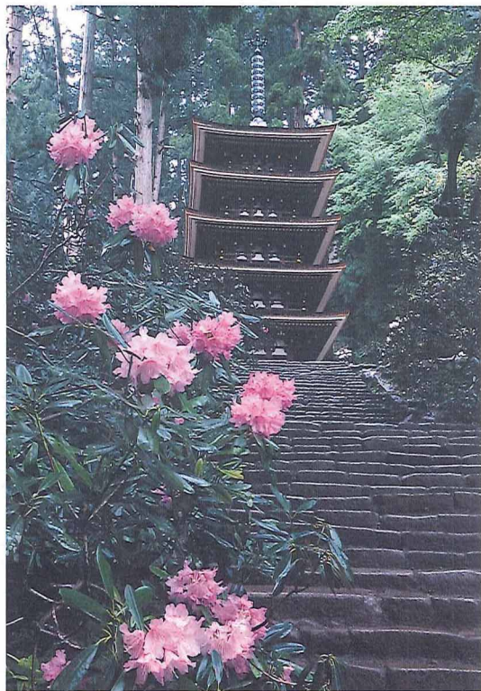
修復された室生寺五重塔（室生村）
