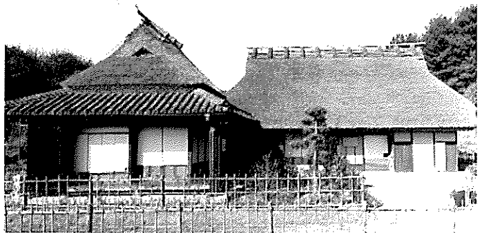
▲外観（右手は旧萩原家、左手は旧赤土家離座敷）
