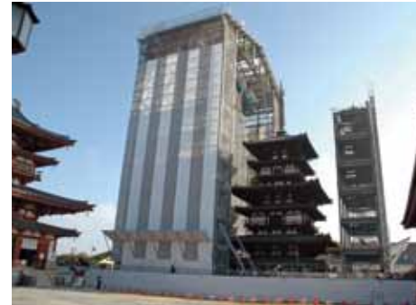
素屋根建設中(平成24年2月)
