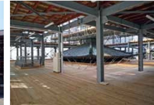
素屋根内部の状況
