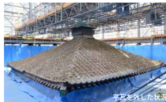
丸瓦と丸瓦下の砂漆喰を外した状況
