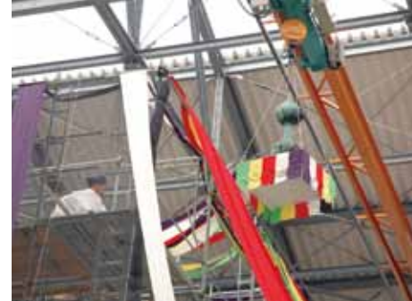
宝珠・竜舎の解体(平成24年6月)
