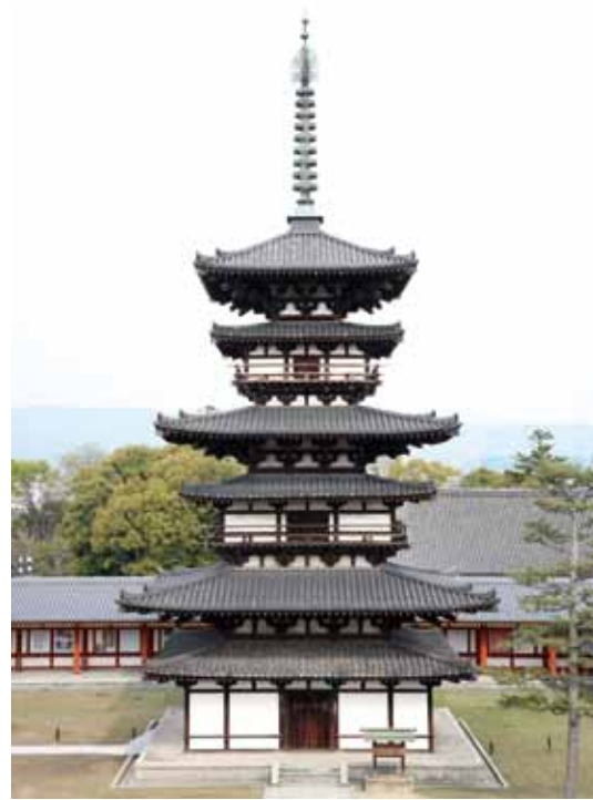
修理前の東塔
