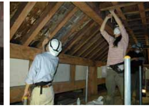
初層内部彩色の応急処置作業(平成23年9月)
