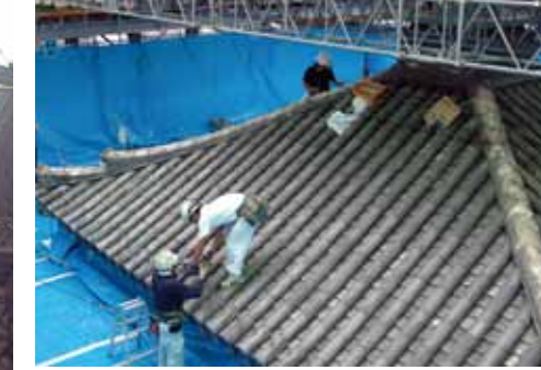
瓦下ろし開始(平成24年9月)
