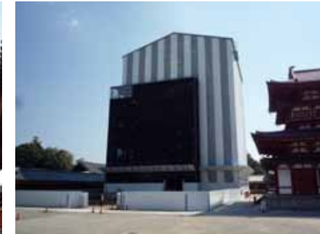
素屋根完成(平成24年3月)
