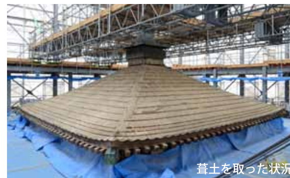
平瓦を外した状況
