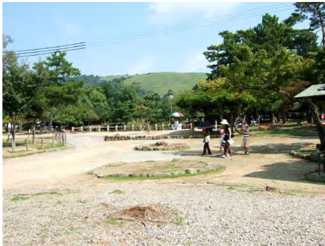
■平坦部における古木の枯死や伐採跡の状況
