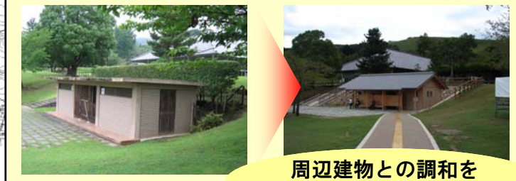
【春日野園地】・トイレ改築
