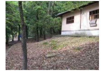
【若草山麓】 ・トイレ改築 ・園地整備
