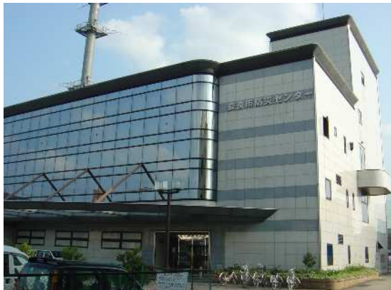
防災センター
