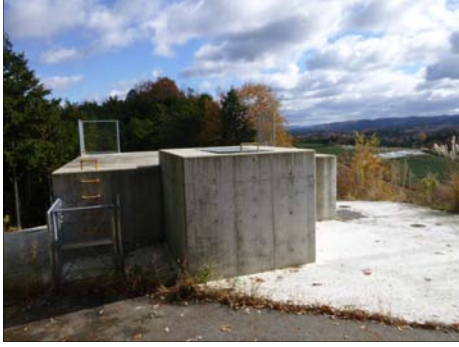
ファームポンド（貯水槽）
