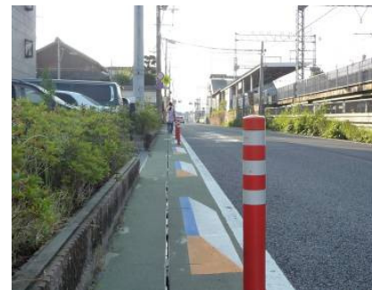
写真 側溝の蓋かけ例 (大和高田市築山)
