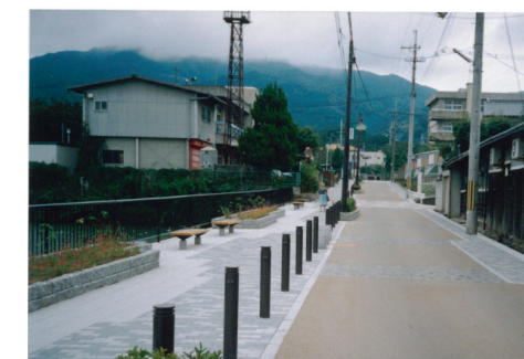
写真 歩道にベンチを設置した例 (天理市柳本町)
