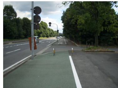
写真 緑色舗装による自転車の通行位置明示 (大和中央自転車道)
