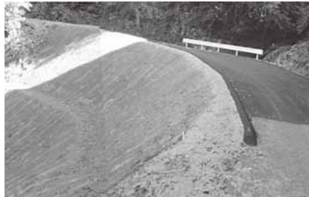
写真111 平成24年8月20日 林道サンギリ線3号 竣工後 (上北山村河合地区)
