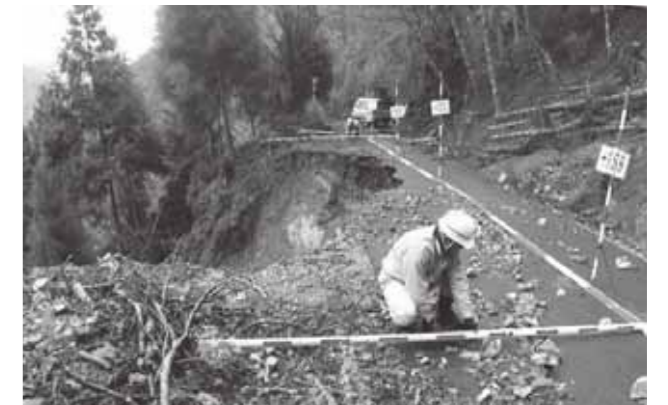
写真104 平成23年10月2日 林道小谷線2号 着工前（上北山村河合地区）
