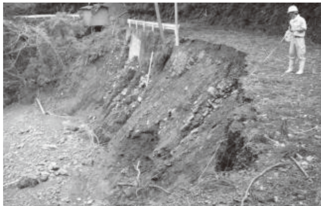
写真108 平成23年9月11日 林道片川線2号 着工前 (十津川村小山手地区)
