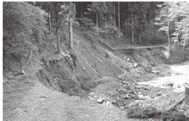
写真116 平成23年9月10日 林道果無谷線1号 着工前 (十津川村上湯川地区)
