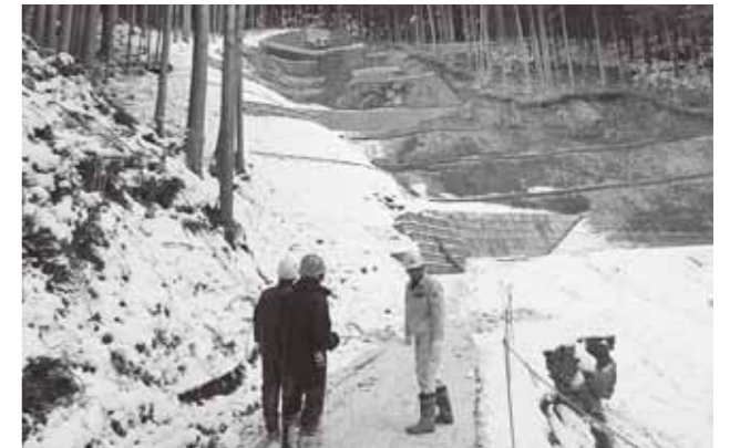
写真 92 平成 24 年 12 月 26 日 1号、2号土留工完成、筋工施工中 (天川村川合地区)
