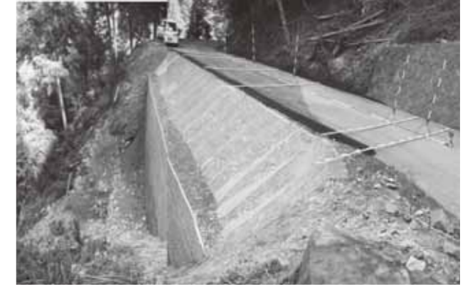
写真105 平成24年7月26日 林道小谷線2号 竣工後（上北山村河合地区）
