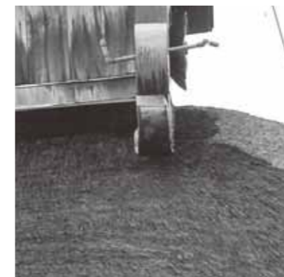
写真121 金峯山寺本堂檜皮葺き修理後
