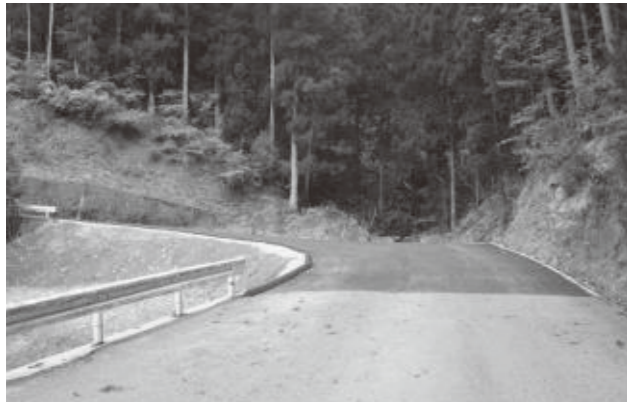
写真107 平成24年5月17日 林道川津今西線2号 竣工後 (十津川村川津地区)
