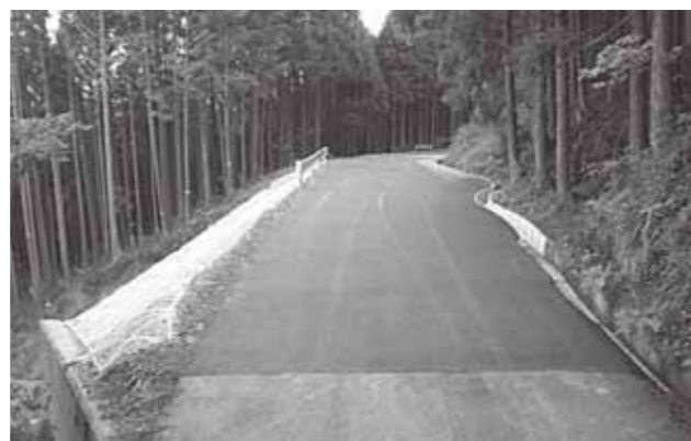
写真113 平成24年6月27日 林道中の山田線1号 竣工後 (首爾村塩井地区)
