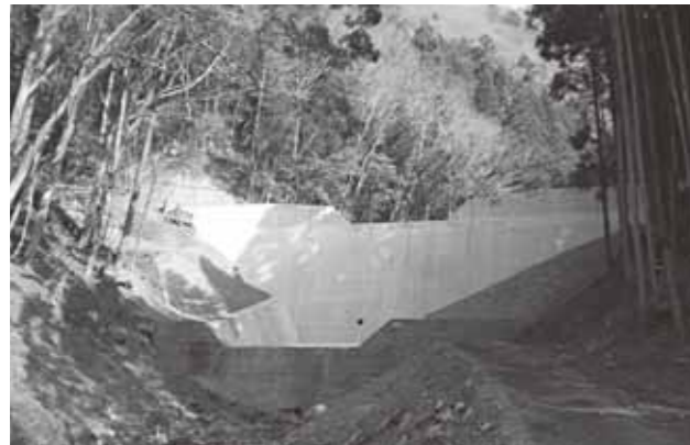
写真94 平成25年2月1日 1号谷止工完成（十津川村長殿地区テラ谷）
