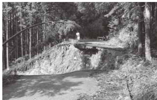
写真112 平成23年9月27日 林道中の山田線1号 着工前 (首爾村塩井地区)
