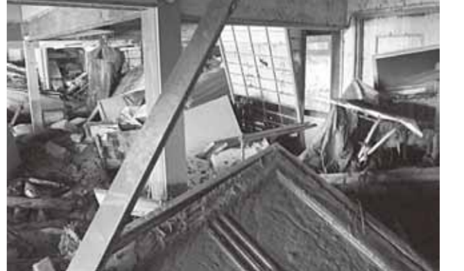
写真146 全壊した住宅の被害の様子
