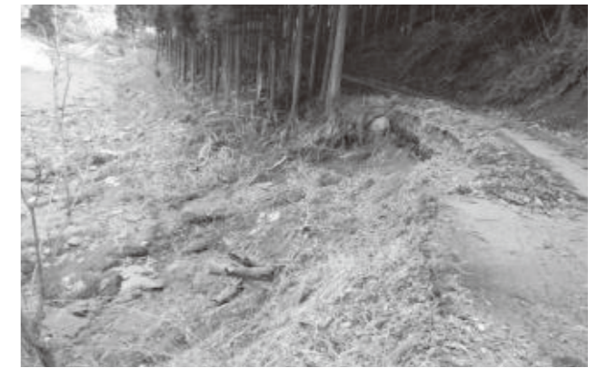
写真102 平成24年3月30日 林道篠原線2号着工前（五條市大塔町篠原地区）
