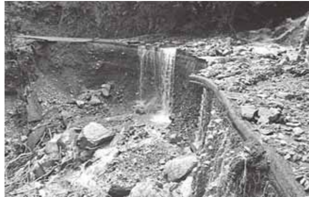
写真110 平成23年9月6日 林道サンギリ線3号 着工前 (上北山村河合地区)
