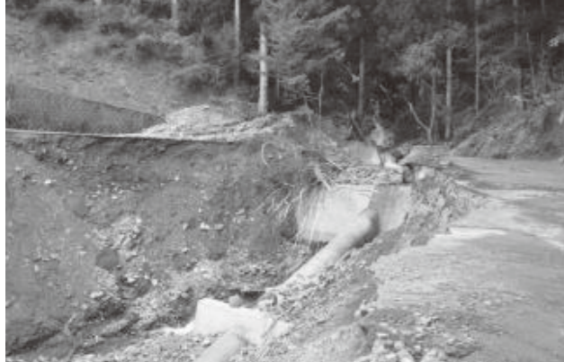
写真106 平成23年9月12日 林道川津今西線2号 着工前 (十津川村川津地区)
