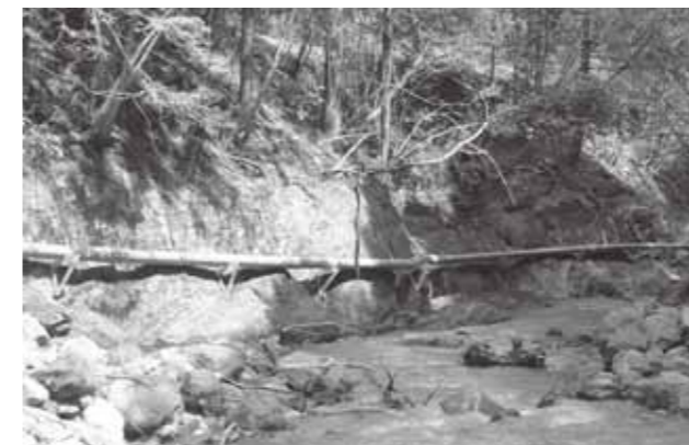
写真118 平成24年3月28日 十津川村漁業協同組合導水管の復旧 施工後
