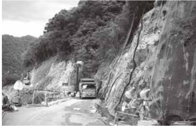
写真135 建設業協会による緊急対応状況（十津川村桑畑地区）
