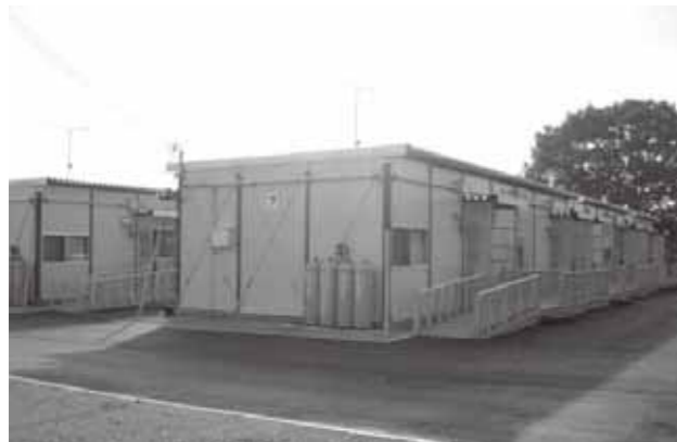
写真123 五條市応急仮設住宅（五條住宅）
