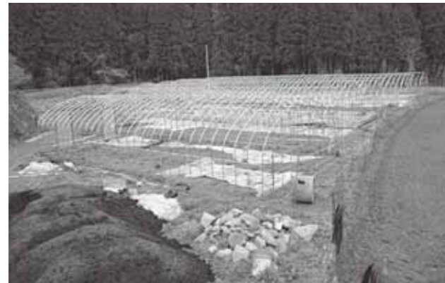
写真 89 平成 24 年 3 月 復旧後のパイプハウス (曾爾村)
