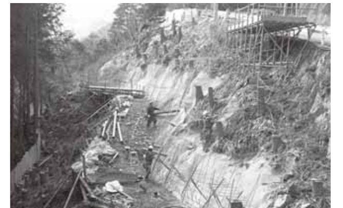
写真 93 平成 25 年 1 月 25 日 アンカー工固定用受圧板施工中 (五條市大塔町堂平地区)
