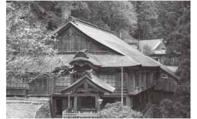
写真122 玉置神社屋根修理後
