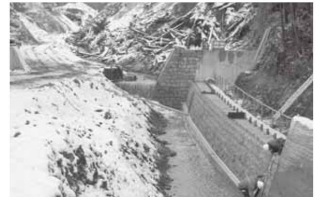
写真 91 平成 24 年 12 月 26 日 1号床固工完成、1号護岸工施工中、排土工施工 (天川村坪内地区)
