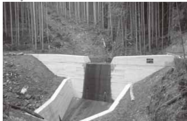
写真99 平成24年10月25日 竣工後（曾爾村長野地区）
