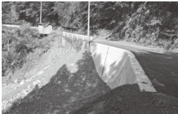
写真109 平成24年8月9日 林道片川線2号 竣工後 (十津川村小山手地区)
