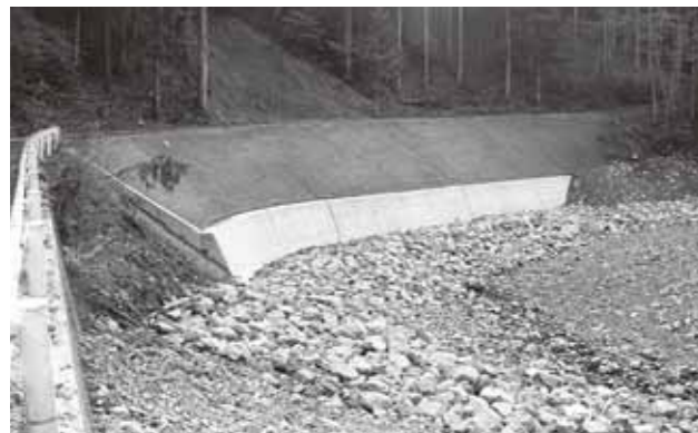
写真117 平成24年10月16日 林道果無谷線1号 竣工後 (十津川村上湯川地区)
