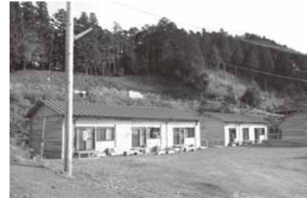
写真 130 十津川村応急仮設住宅(谷瀬住宅)
