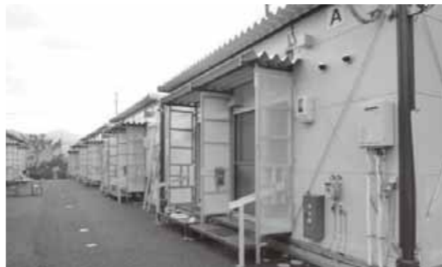
写真 127 五條市応急仮設住宅(大塔住宅)
