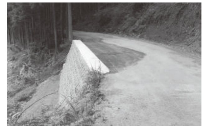
写真103 平成24年6月15日 林道篠原線2号 竣工後（五條市大塔町篠原地区）
