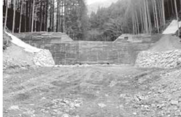
写真101 平成25年1月10日 竣工後（御杖村神末ケヤキ谷地区）
