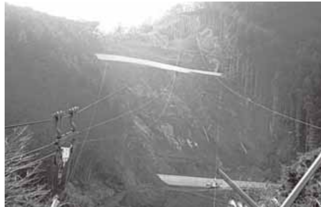
写真95 平成25年2月7日 1号、2号土留工完成（十津川村折立地区）
