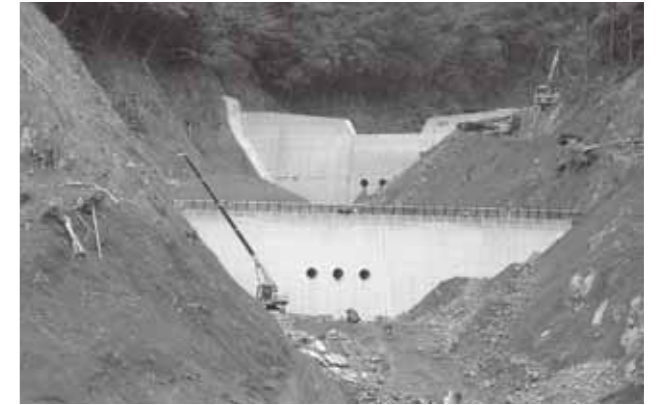
写真 90 平成 25 年 2 月 5 日 2号谷止工施工中、3号谷止工完成 (十津川村野尻地区)
