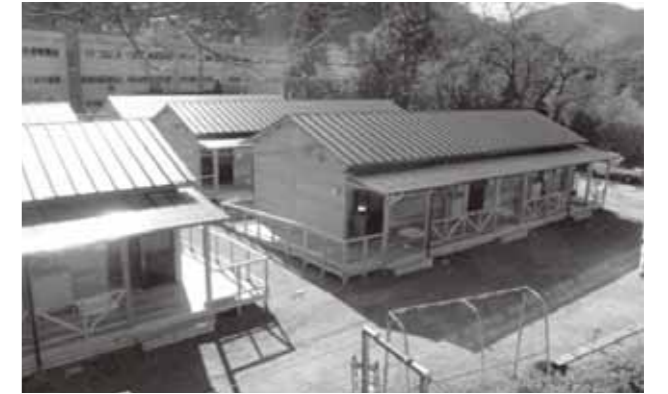
写真125 十津川村応急仮設住宅（平谷住宅）
