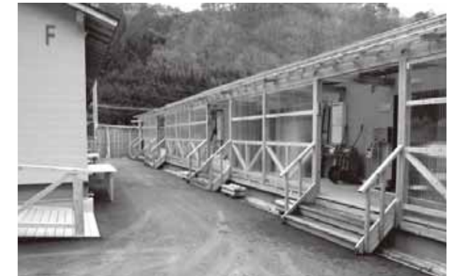
写真 132 野迫川村応急仮設住宅の追加工事(北股住宅)
