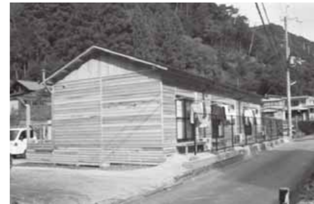
写真 129 十津川村応急仮設住宅(沼田原住宅)
