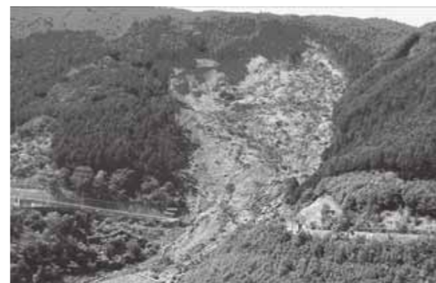
写真140 平成23年9月7日 国道169号崩壊現場
