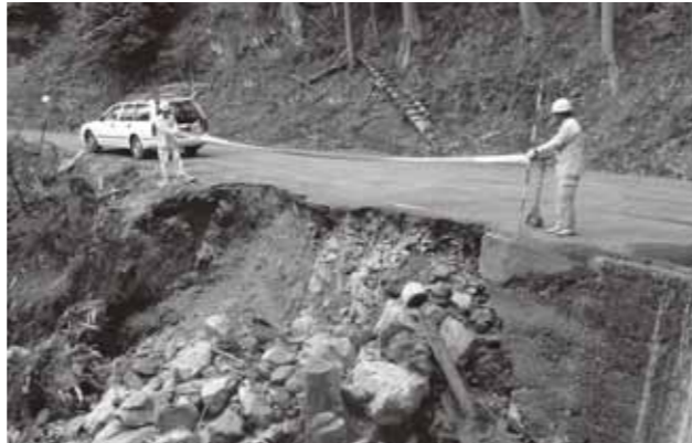
写真137 川津高野線（十津川村杉清地区）の調査状況
