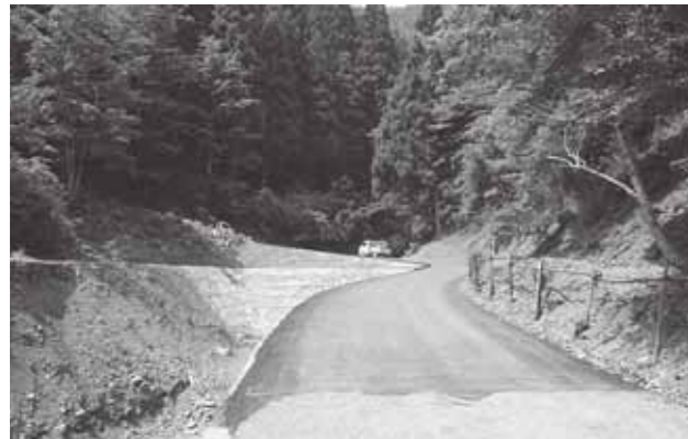
写真115 平成24年6月15日 林道旭沢ノ谷線1号 竣工後 (十津川村旭地区)
