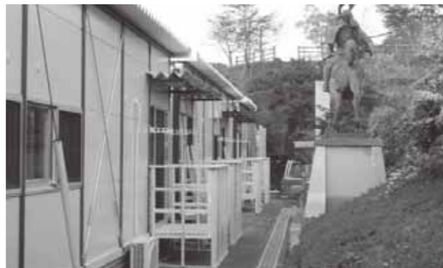
写真 128 五條市応急仮設住宅(大塔住宅)
