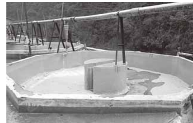
写真119 平成24年3月29日 野迫川村大股漁業生産組合養殖池の復旧 施工後
