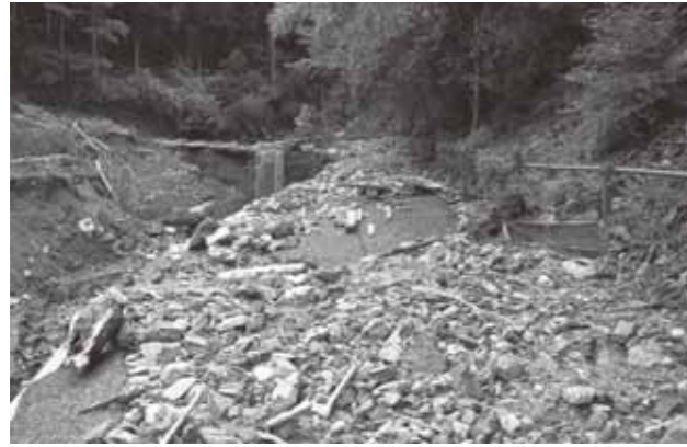
写真114 平成23年9月12日 林道旭沢ノ谷線1号 着工前 (十津川村旭地区)
