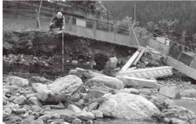
写真136 高見川（東吉野村小津地区）の調査状況
