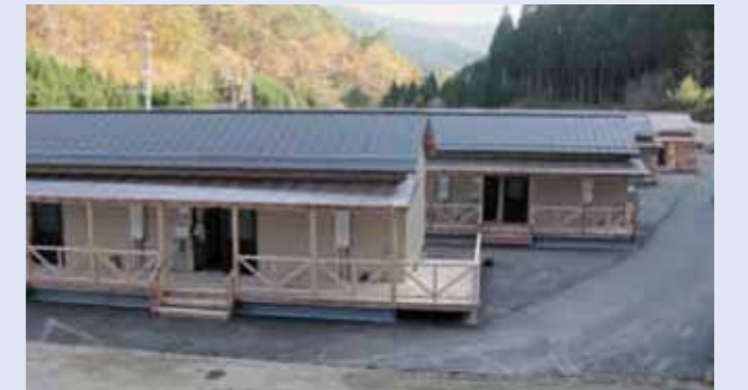
応急仮設住宅（野迫川村北股地区）
