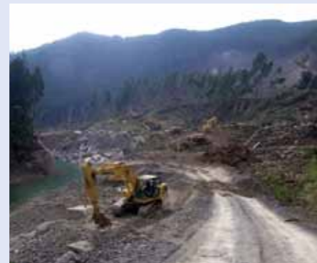
天川村坪内地区の応急復旧活動 社奈良県建設業協会
